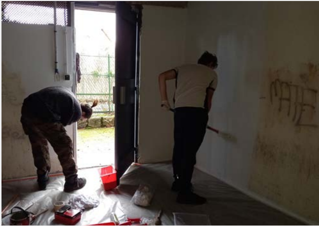
Peinture du local à vélos de la résidence Bergson.
